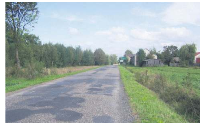
W Dorbozach (gm. Obsza) przy drodze powiatowej powstanie chodnik.
