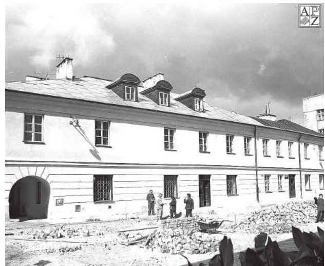
Przy ul. Greckiej powstaje parking. To zdjęcie wykonano prawdopodobnie w latach 70. ub. wieku. Fot. ze zbiorów APZ
