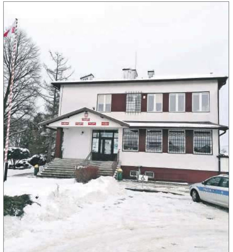
Urząd Gminy to jeden z budynków, które wymagają remontu.
