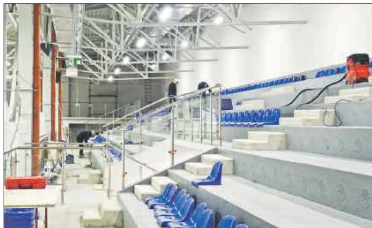
Ostatnie prace na lodowisku przy ul. Piłsudskiego.
