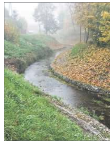
W Zawadzie zostanie zabezpieczona skarpa przy potoku Zawadka.
