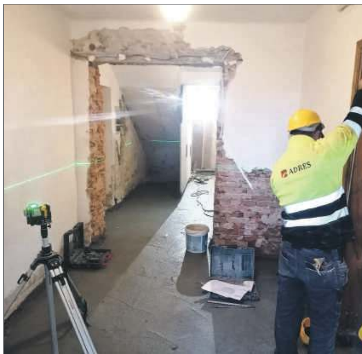
Prace w dworku zakończą się jeszcze w tym roku.
