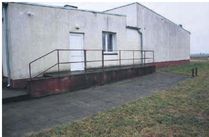
Jedną z zaplanowanych inwestycji na 2021 rok jest rozbudowa i przebudowa siedziby B-CKiP w Lubiewie w celu utworzenia klubu seniora. Dobudówka powstanie z prawej strony domu kultury (na zdjęciu). Inwestycja pochłonie 1.037.104,43 zł. Z zewnętrznego dofinansowania pochodzi 968.104,43 zł.
