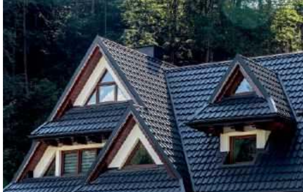
🔗 Na dach z lukarnami i wieloma załamaniami, lepiej wybrać blachę modułową, niż długie arkusze. BUDMAT
