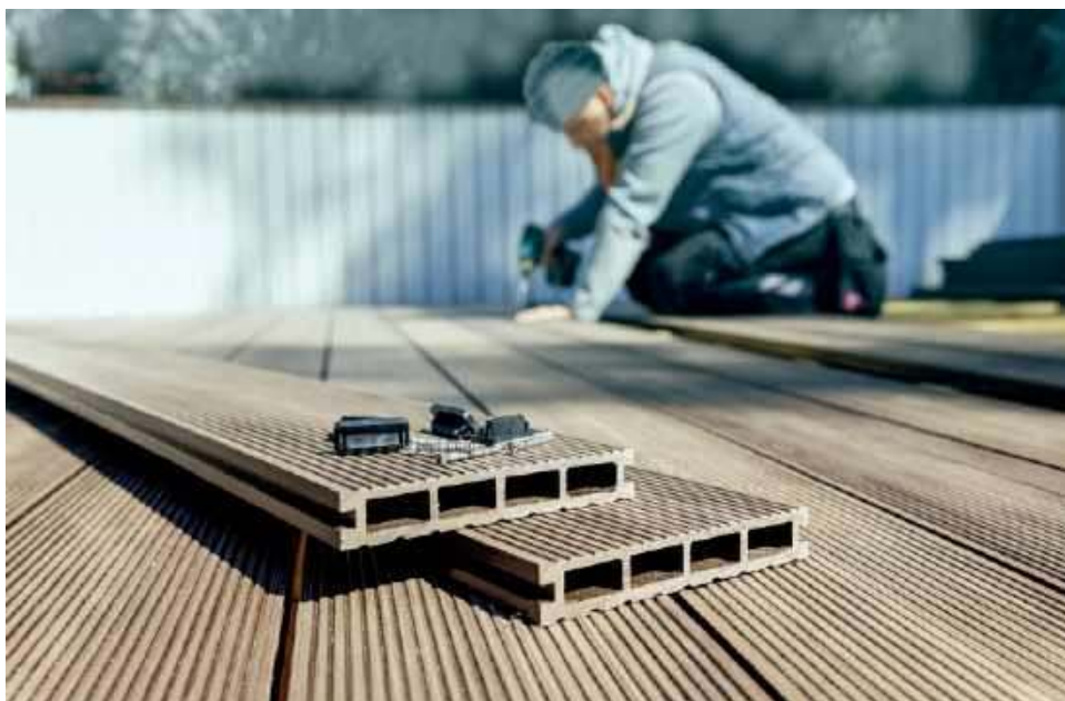
Deski kompozytowe występują w wersji komorowej lub pełnej. Te pierwsze są tańsze i lżejsze, ale wymagają większej liczby legarów, zapewniających stabilność konstrukcji. JAF POLSKA
