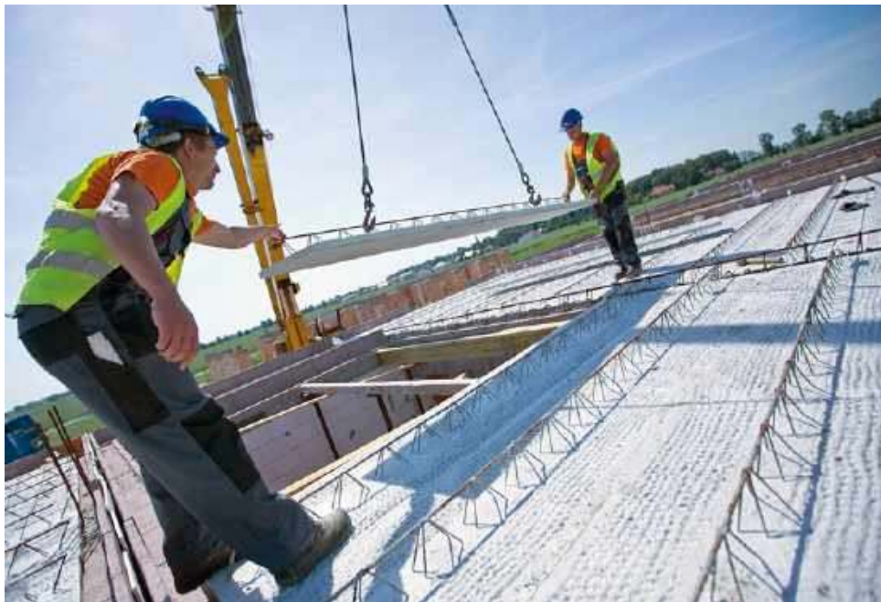
🔗 Zastosowanie prefabrykatów pozwala zaoszczędzić czas i zminimalizować ryzyko popełnienia błędów podczas budowy. STROPY.PL
