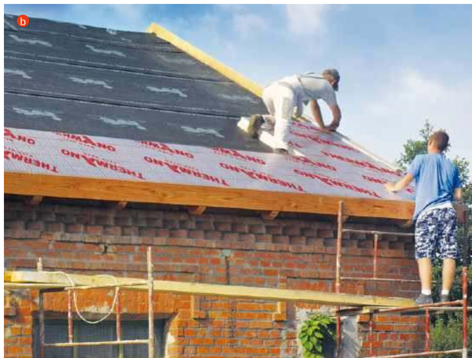
📌 Izolacja nakrokwiowa sprawdza się w budynkach nowych (a) i modernizowanych (b). BALEX METAL
