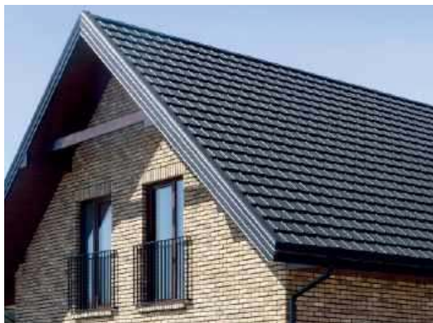
🔗 Na prostym dwuspadowym dachu, można ułożyć arkusze nawet o długości równej połaci dachu. RUUKKI
