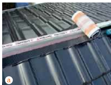
🔥 Montaż taśmy zabezpieczającej kalenicę (a WIENERBERGER) i kłamy do gąsiorów na kalenicy (b BMI BRAAS).
