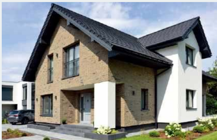
📌 Elewację wykończono ręcznie formowaną cegłą elewacyjną i tynkiem silikonowym.
