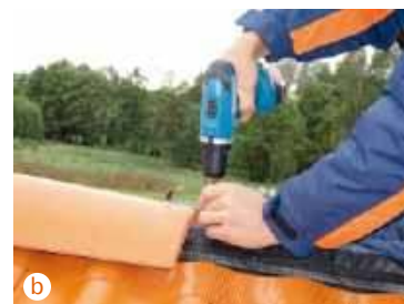
🔥 Montaż taśmy zabezpieczającej kalenicę (a WIENERBERGER) i kłamy do gąsiorów na kalenicy (b BMI BRAAS).
