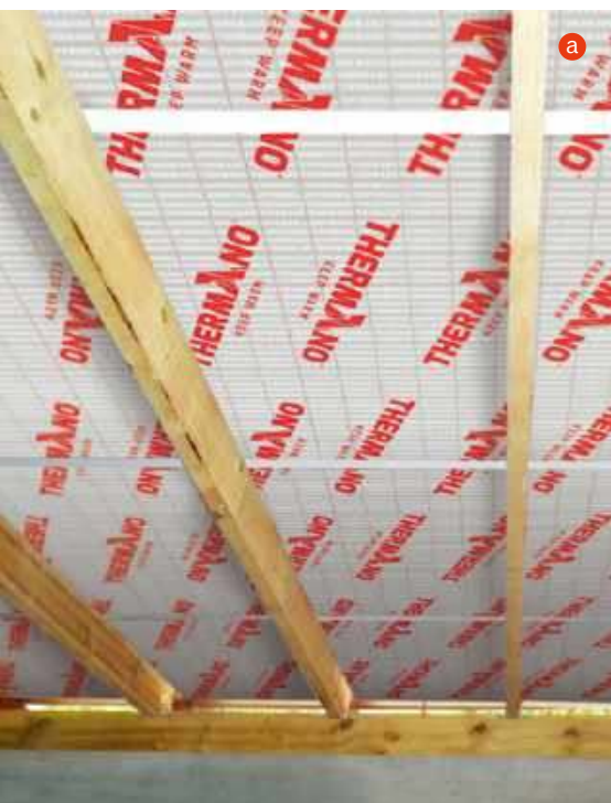
📌 Izolacja nakrokwiowa sprawdza się w budynkach nowych (a) i modernizowanych (b). BALEX METAL
