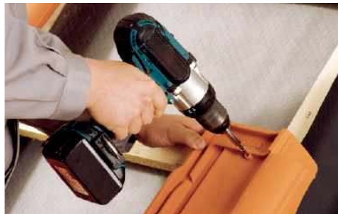
Montaż dachówki bocznej. CREATON POLSKA
