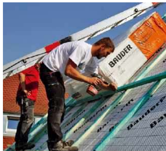
Płyty PIR mocuje się do krokwi wkrętami, wprowadzanymi przez kontrłaty. BAUDER
