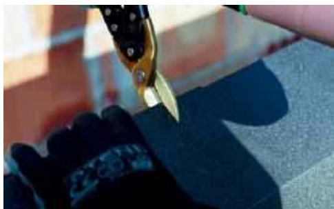
🔗 Blachodachówkę przecina się specjalnymi nożycami. Zastosowanie na dachu szlifierki kątovej powoduje uszkodzenie powłoki pokrycia. BLACHY PRUSZYŃSKI
