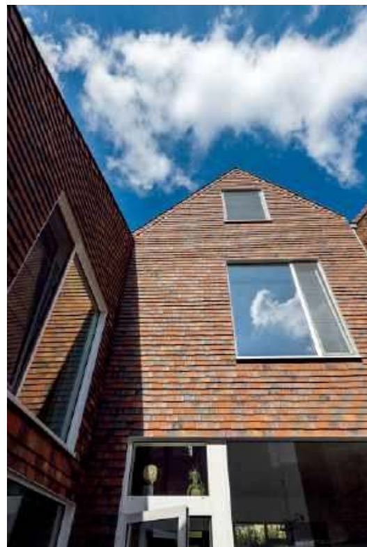
Modne obecnie jest wykończenie elewacji dachówką, wygląda wtedy jak przedłużenie połaci dachu. CREATON POLSKA (PROJEKT KLUJ ARCHITEKCI), WIENERBERGER
