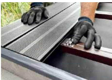
Deski, bez względu na to czy są wykonane z drewna czy z kompozytu, zawsze układa się na legarach z niewielkim spadkiem w stronę ogrodu. RENOPLAST
