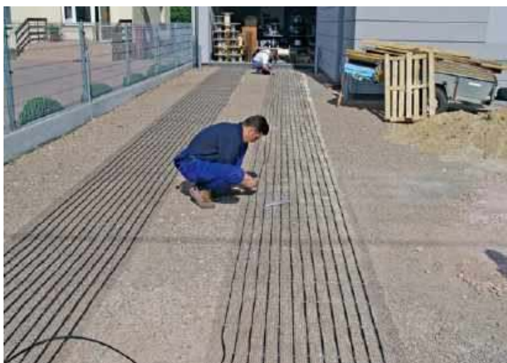
Instalacji przeciwooblodzeniowej często nie trzeba układać na całym podjeździe – wystarczy zamontować ją na pasach wytyczonych przez tor jazdy kół samochodu. FENIX POLSKA
