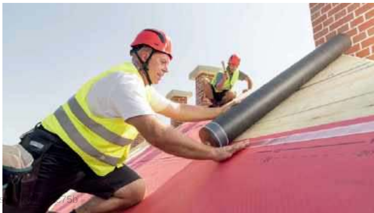
🔗 Dachówki można też układać na deskowaniu z membraną. WIENERBERGER
