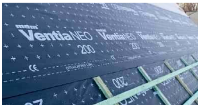
Na deskowaniu układa się membranę, którą trzeba szybko przykryć. MDM NT
