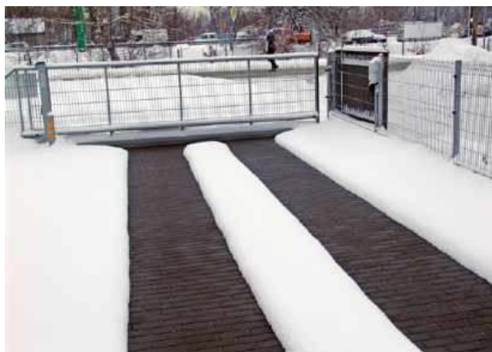
Instalacji przeciwooblodzeniowej często nie trzeba układać na całym podjeździe – wystarczy zamontować ją na pasach wytyczonych przez tor jazdy kół samochodu. FENIX POLSKA
