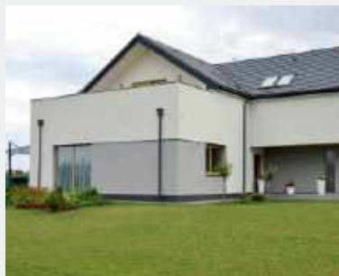
🔗 Podziały o różnej głębokości (efekt 3D) powstały po przyklepieniu styropianu o grubości 12 i 20 cm.
