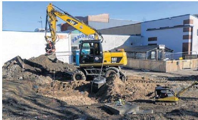
Budowa masztu stacji bazowej P4 przy ul. Tuwima
