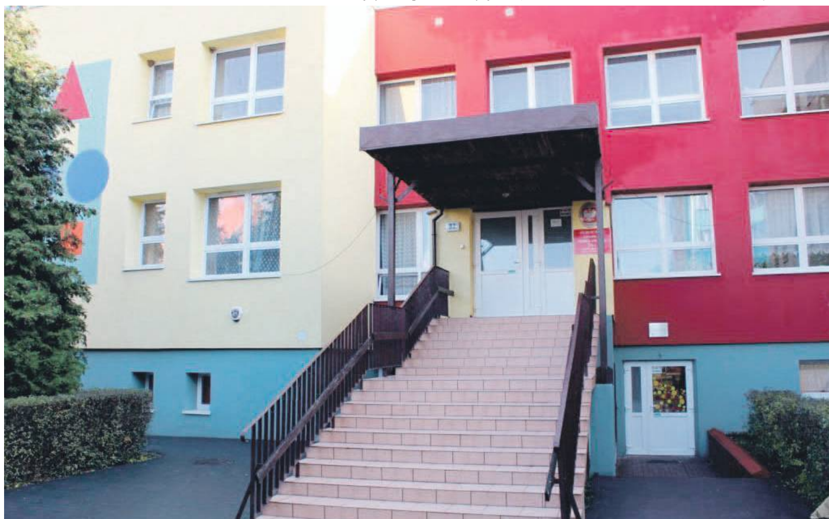
PSP nr 3 ma dwa budynki. Jeden z nich mieści się przy ul. Hirszfelda, gdzie otoczony jest osiedlowymi blokami. Dlatego rozbudowa wydaje się trudna
