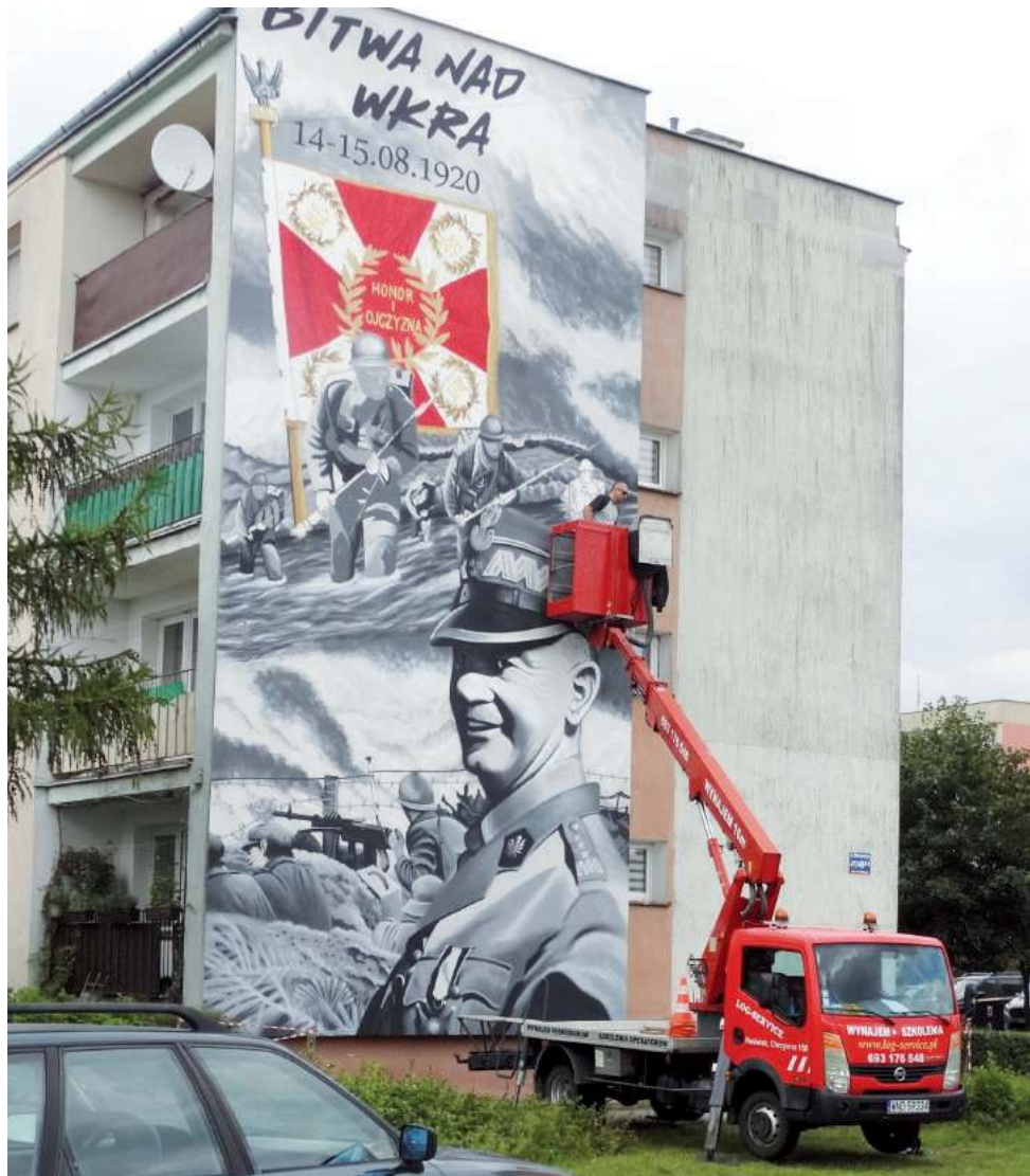
Prace idą pełną parą
