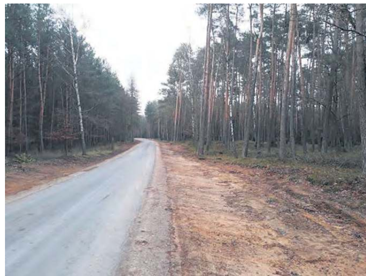
Nowa droga w kierunku Leontynowa.
