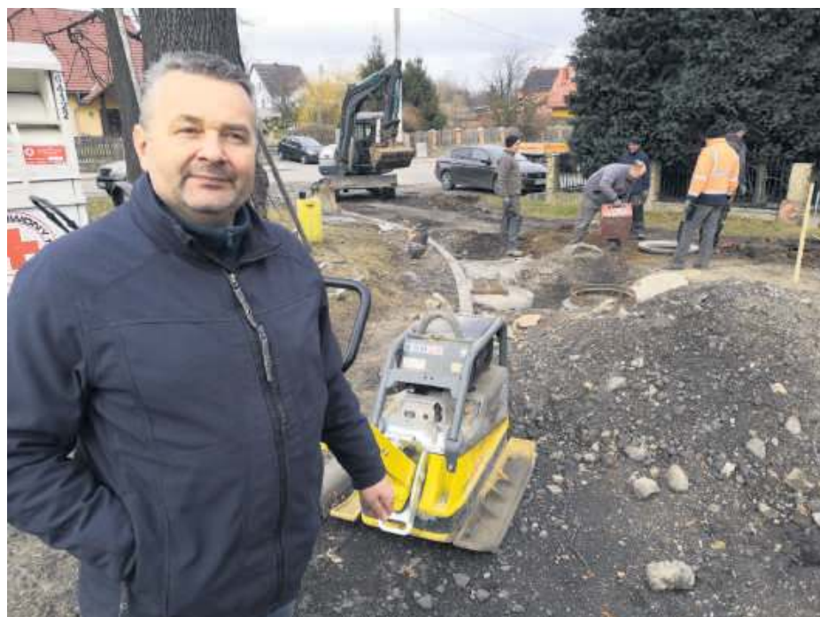
Tomasz Bartków, właściciel firmy realizującej gminne zadanie, uważa, że jak dobrze pójdzie, to w przyszłym tygodniu zostanie położony asfalt
