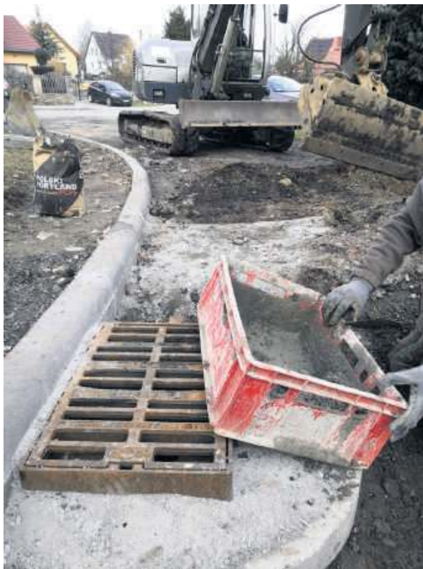
Droga jest tak wyprofilowana, że wody opadowe, płynąc wzdłuż krawężnika, wpadają będą do kanałów kanalizacji burzowej
