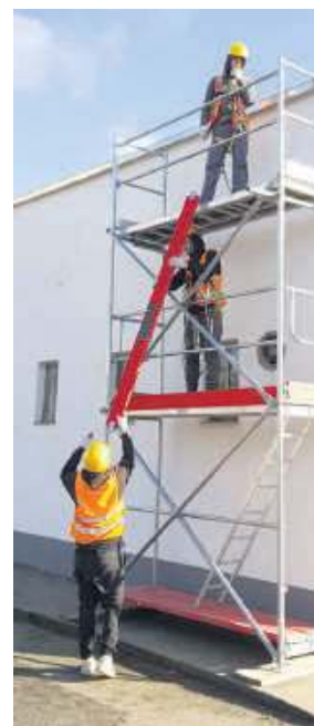
Rusztowanie budowlane musi być solidne i bezpieczne. Foto: CKZiU Strzelin
