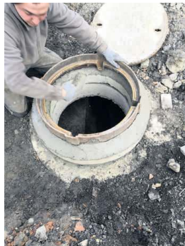
Odpowiednie poziomowanie wjazdów do studni kanalizacji deszczowej
