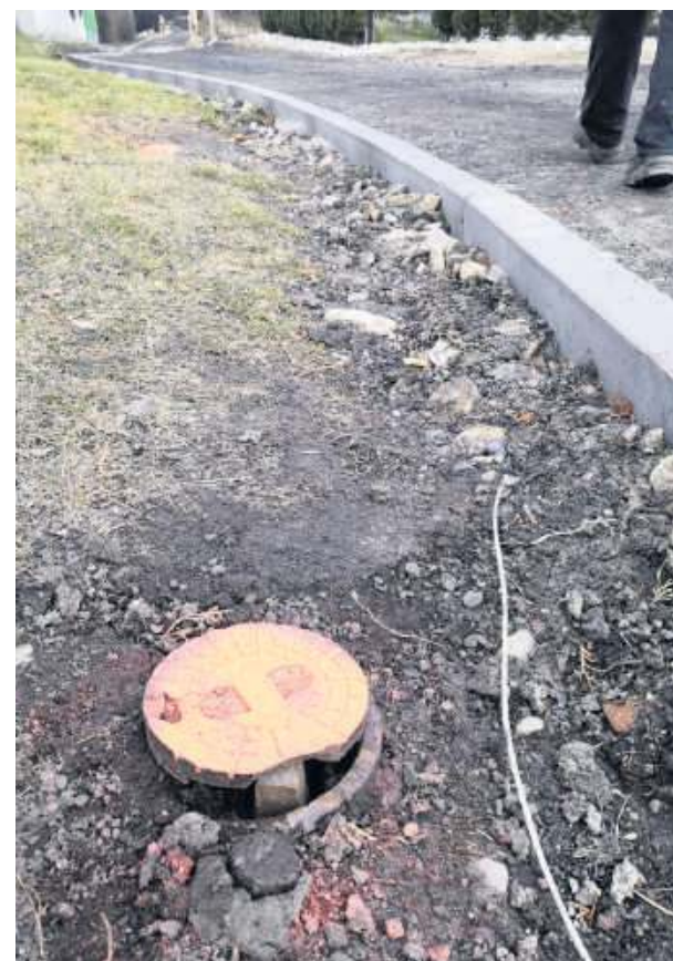
W wielu miejscach wykonawca musiał znaleźć schowane pod ziemią skrzynki zasuw wodociągowych. Zostaną one podniesione do wysokości terenu, aby można było z nich ewentualnie skorzystać, jeżeli będzie taka potrzeba w przyszłości
