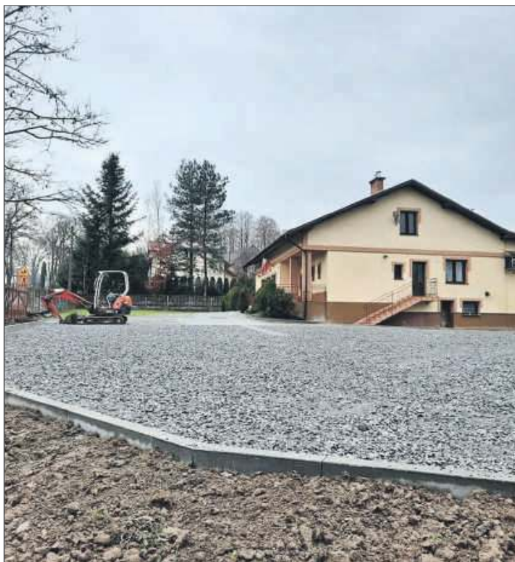
Żeby wybudować parking Rada Sołecka wykupiła sąsiednią działkę.
