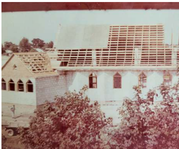
Prace budowlane rozpoczęły się w marcu 1983 r.
