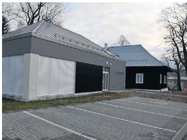
Prace przy centrum zostały zakończone
