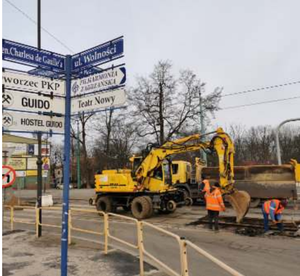
► Remontowany odcinek ul. Wolności Fot. UM Zabrze
