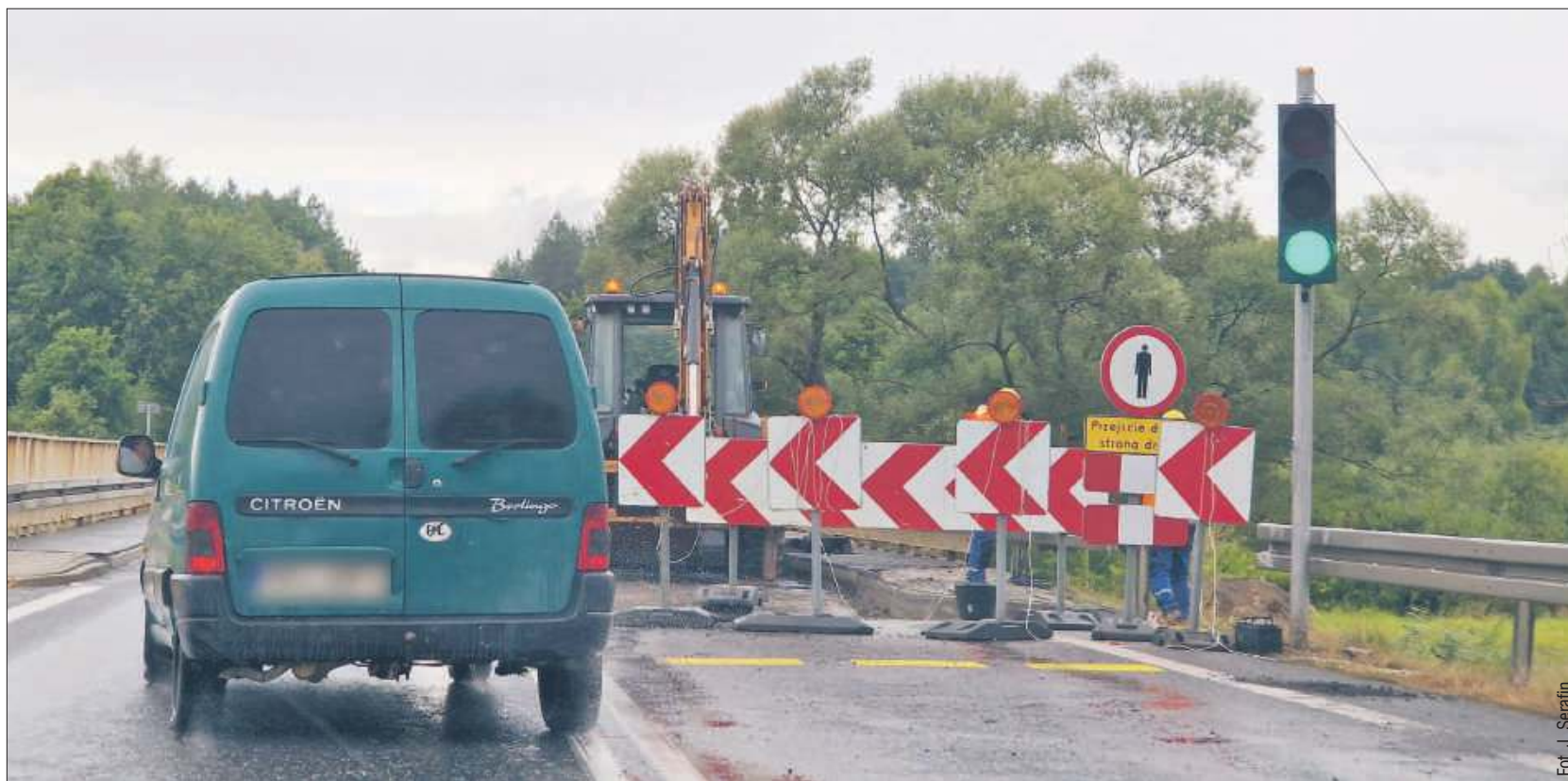
Remont mostu w Zarębkach został rozpoczęty.
