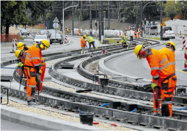
• Budowa linii tramwajowej. Skrzyżowanie ul. Puławskiej i Spacerowej FOT. ROBERT KOWALEWSKI / AGENCJA WYBORCZA.PL
