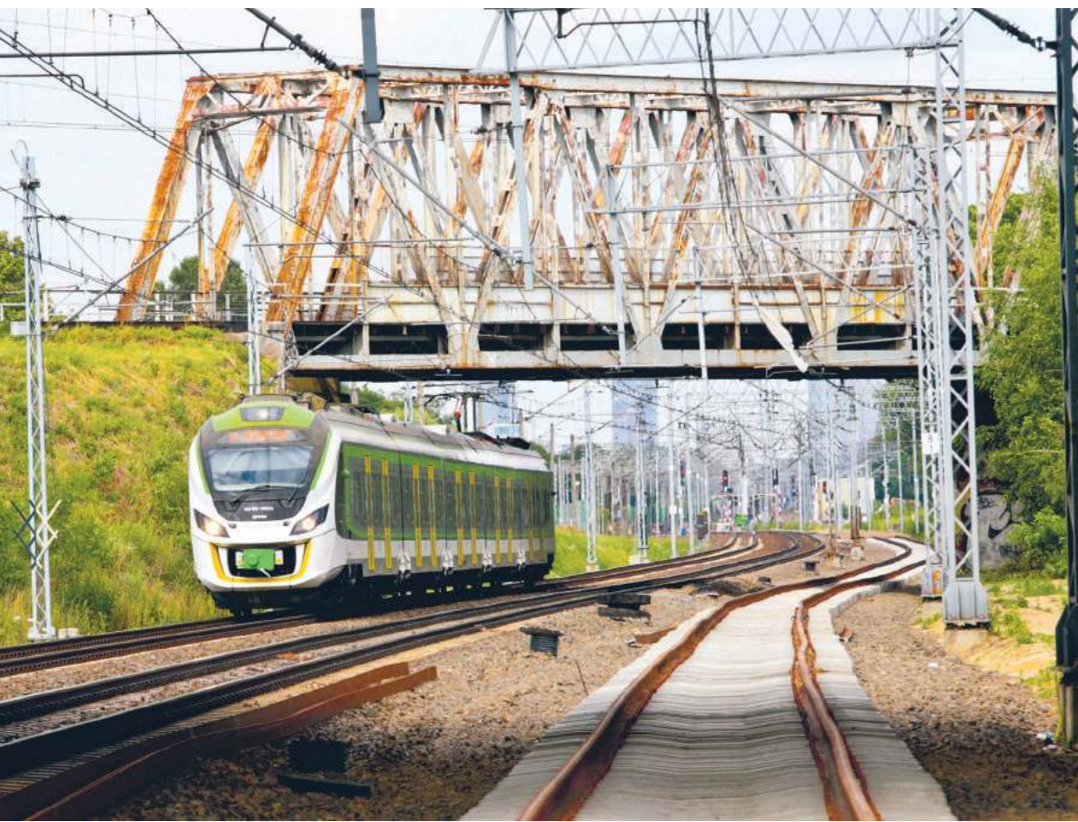
zakończenie prac na stacji w Pruszkowie | fot. Tomasz Hamrat/Gazeta Polska
