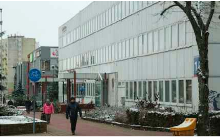
Charakterystyczny „blaszak”, w którym przez kilkadziesiąt lat miał swoją siedzibę urząd miasta, zapewne przez nowego właściciela nieruchomości zostanie rozebrany
