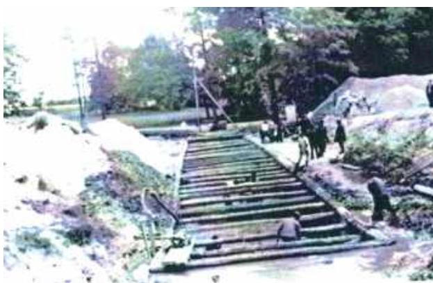
Budowa linii kolejowej
