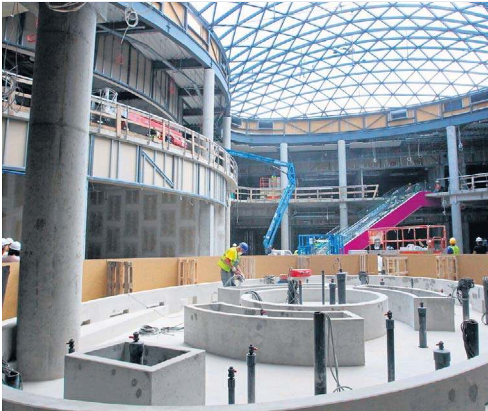
Prowadzona 14 lat temu w ekspresowym tempie budowa dworca w Poznaniu... okazała się budową centrum handlowego
