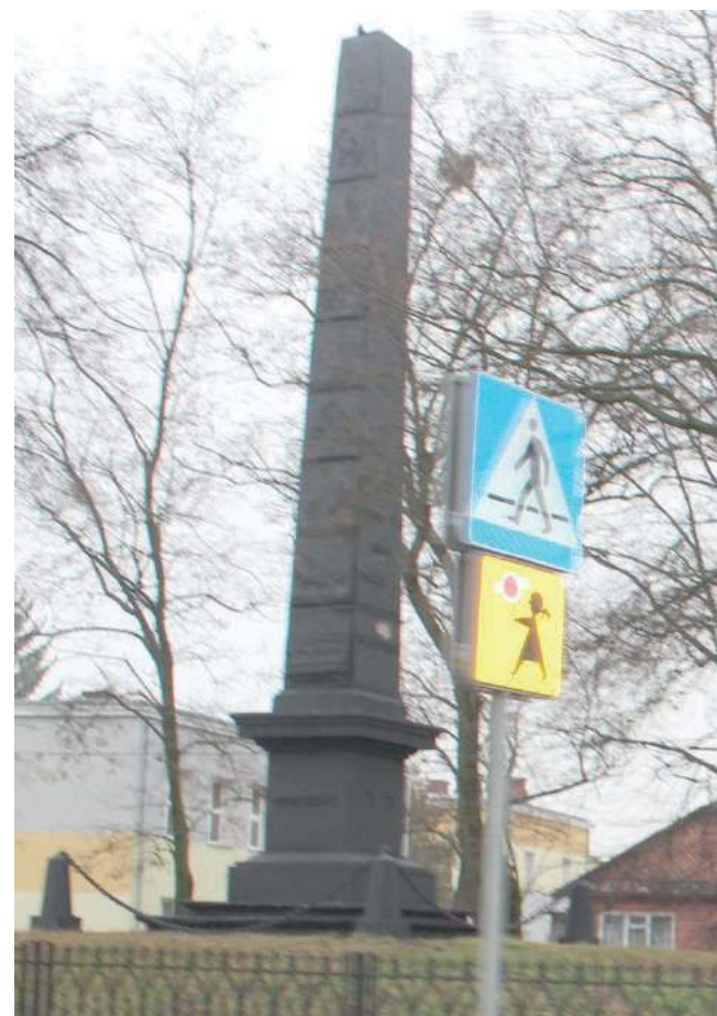
Pomnik Traktu Brzeskiego. Wykonawca ma ustalić przyczyny osiadania pomnika, zdemontować część tablic, schodów i płaskorzeźb oraz je odnowić
