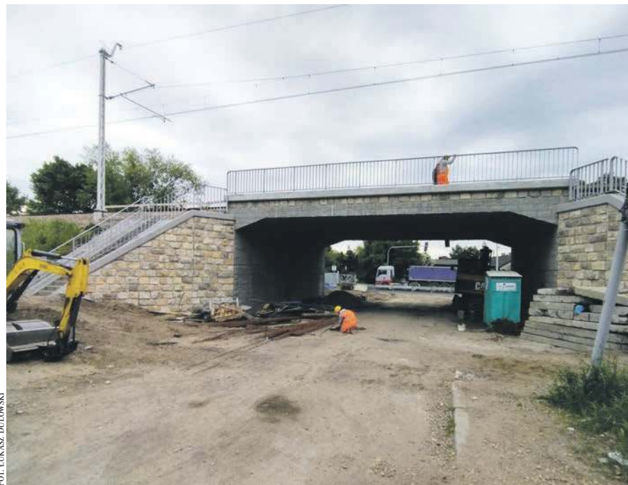
(MK) Wiadukt nad ul. Kadłubek w Chrzanowie
