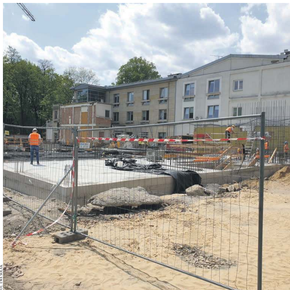
Prace budowlane przy balneologii idą pełną parą
