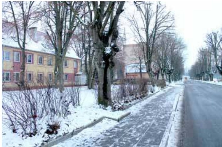
W wyniku śniegów a następnie mrozu utrzymuje się zaśnieżenie a miejscami także zlodowacenie nawierzchni chodników i dróg
