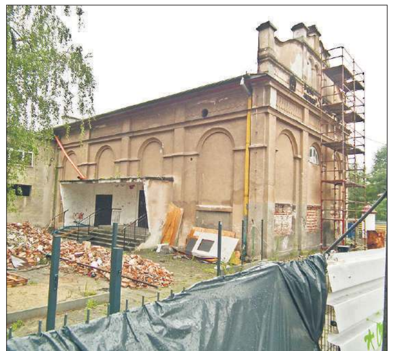
Remont i przebudowa Domu Kultury Śnieżka idą zgodnie z planem.
