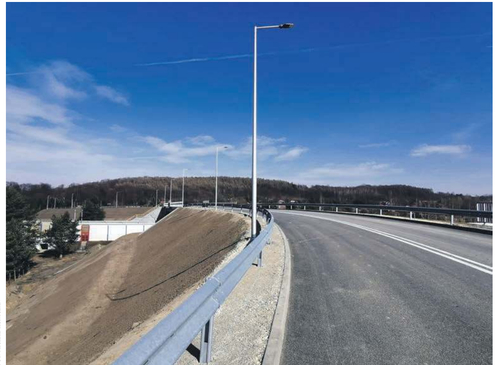
Nowy wiadukt nad torami w Młoszowej
