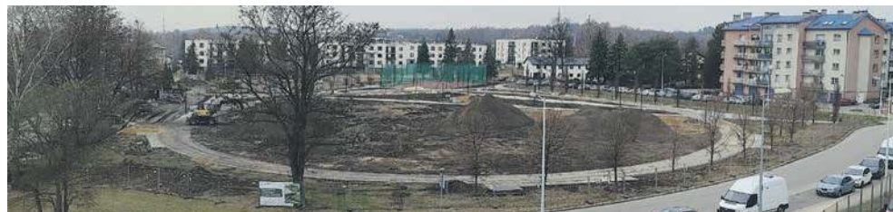
Chrzanowskie Błonia w budowie
