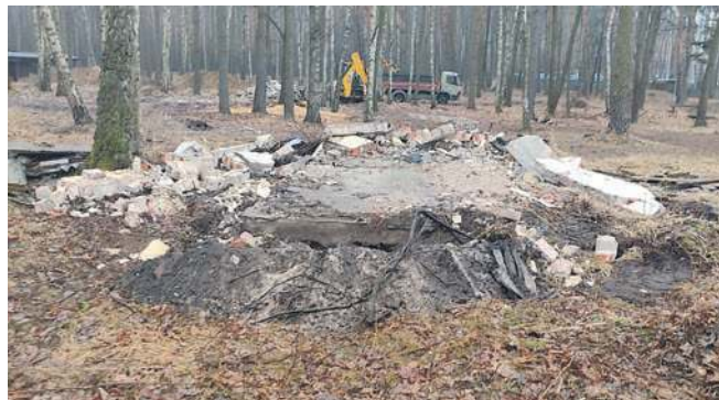
Wyburzone domki letniskowe przy zalewie Chechło
