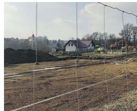
Budowa kompleksu rekreacyjnego w Porębie Żegoty
