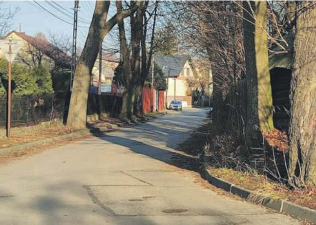
(zew) Będzie remontowana m.in. Starowiejska w Trzebini
