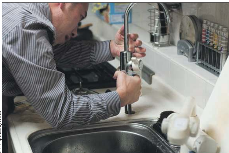
Program obejmuje m.in. pomoc przy uszczelnieniu kranu
