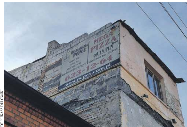
Tablica po Restauracji PePeS przy Szpitalnej w Chrzanowie
