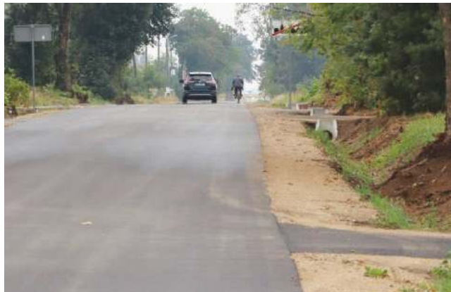
Droga Domosław - Pokrzywnica
