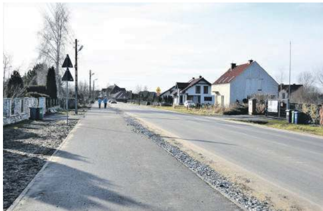
W Szewcach został odebrany ok. 1 km ciągu pieszo-rowerowego wzdłuż ulicy Długiej
