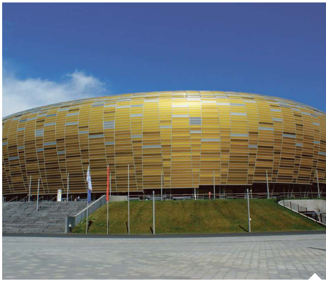
Obiekt w Gdańsku wybudowano przy okazji Euro 2012 | fot. Dariusz Boczek/d
