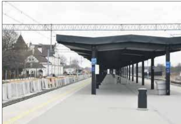
Od połowy grudnia 2021 roku, na stacji Biała Podlaska, podróżni korzystają z nowego wyspowego peronu z wiatą
