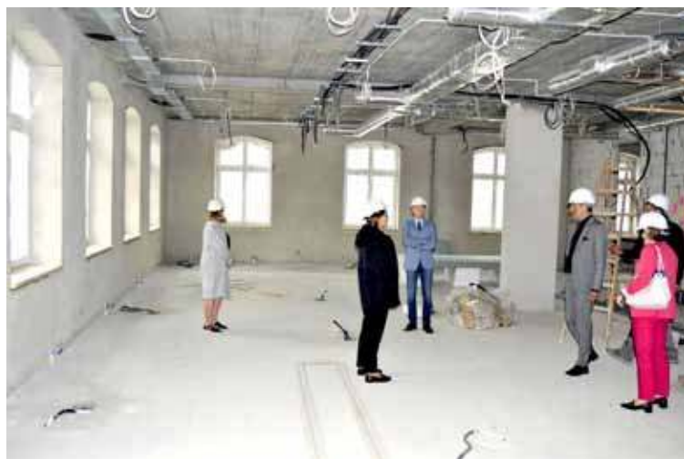
W kamienicy zamontowano już wszystkie okna i zakończono tynkowanie ścian.
