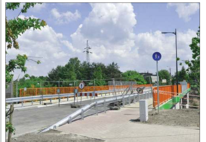
Zakończyła się przebudowa wiaduktu. Prace trwały od listopada 2019 r.
