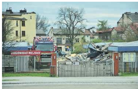
Rozbiórka Targowiska Miejskiego przy Kusocińskiego w Chrzanowie
