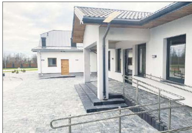
W budynku zastosowano udogodnienia architektoniczne dla osób ze szczególnymi potrzebami
