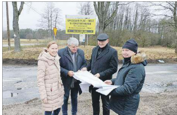
Rusza przebudowa drogi powiatowej na odcinku Horoski Duże – Serpelicie w gminie Sarnaki
