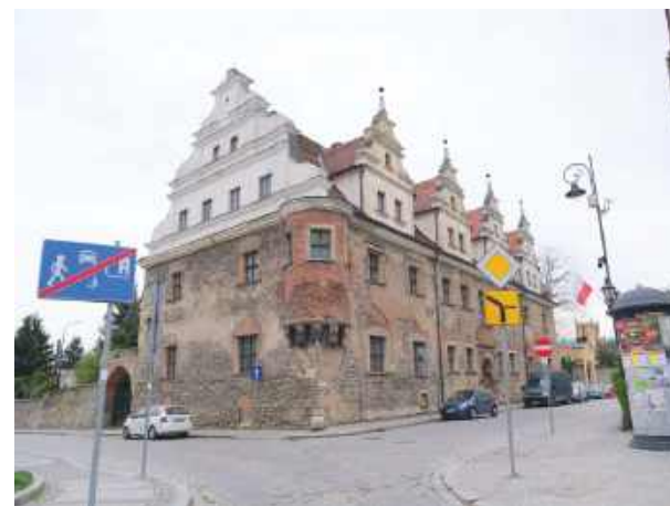
Dach Domu Książąt Brzeskich zostanie zabezpieczony siatką
