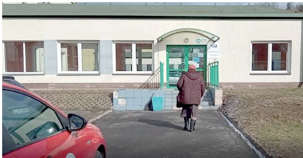
Na czas remontu Przychodnia została przeniesiona do Zespołu Szkół
