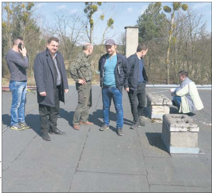
Inspekcja remontowanego dachu
