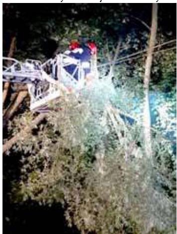
Strażacy z OSP Kunowo usuwali połamaną gałąź, która spadła na linię energetyczną nad ścieżką rowerową w Zieleniewie
