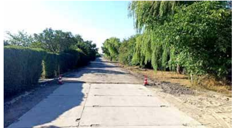
Na odcinku między ulicą Spokojną i Broniewskiego ułożona zostanie masa bitumiczna
