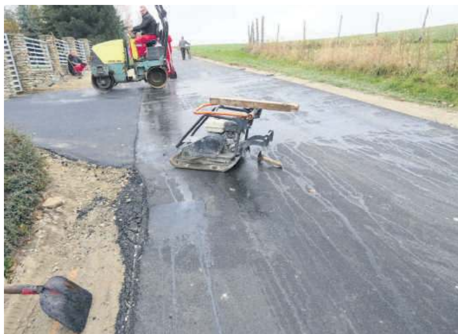
Na drodze tej nadal trwają jeszcze prace wykończeniowe
