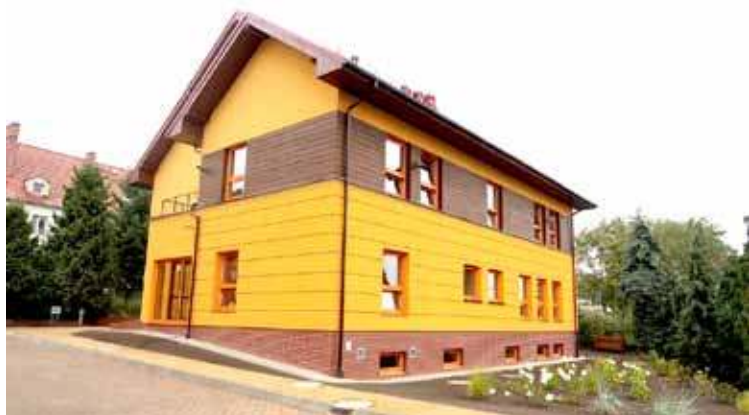
Na zdjęciu nowy budynek noclegowni z miejscami dla 49 osób bezdomnych, który został oddany w październiku b.r.
