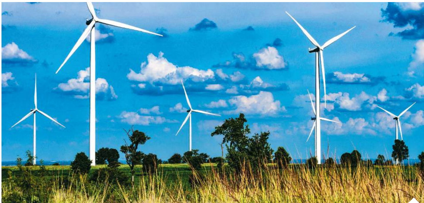
Decyzje o ewentualnym lokalizowaniu nowych lądowych elektrowni wiatrowych rząd chce oddać w ręce społeczności, które miałyby w ich sąsiedztwie mieszkać | fot. AdobeStock/d
