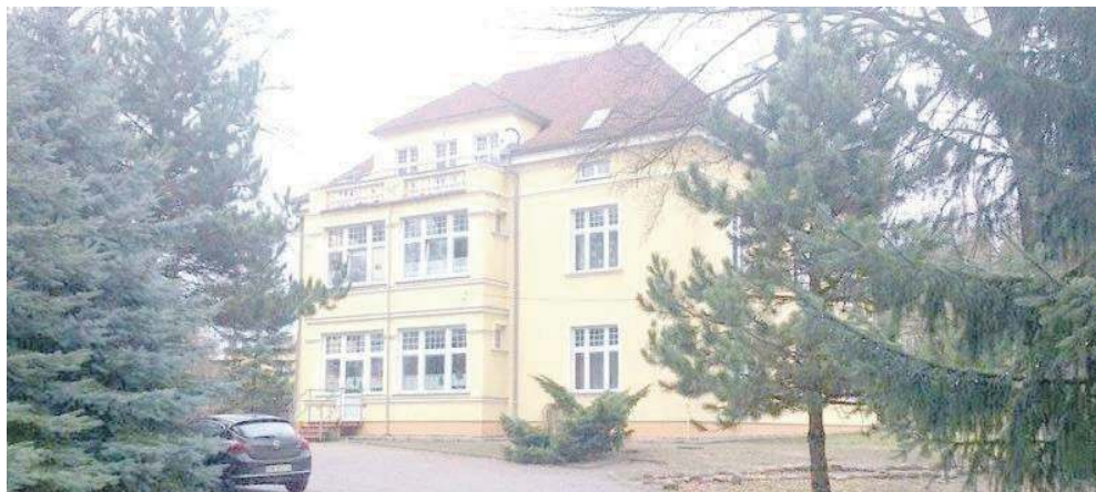
Powiat zamierza kontynuować prace modernizacyjne budynku Domu Dziecka w Obornikach Śląskich
