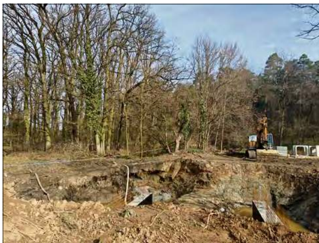
W ramach inwestycji wykonawca prowadzi już roboty rozbiórkowe z całkowitym usunięciem istniejącego przepustu.
