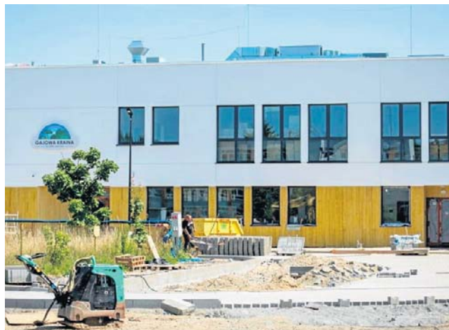
Finiszuje budowa żłobka przy ulicy Gajowej w Bydgoszczy
