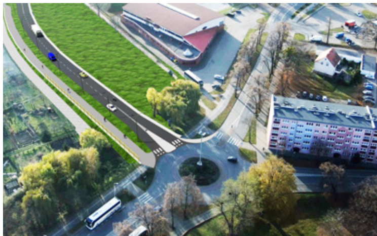
Budowa drogi za wielkie miliony okazała się kłopotem dla urzędników.
