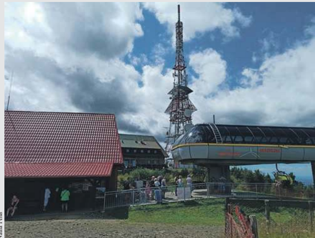
Górna stacja kolejki na szczycie Skrzycznego
