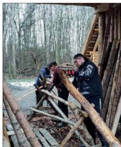
Przed wzniesieniem palisady konieczne było wytyczenie jej śladu oraz wykonanie wykopu, w którym następnie osadzono (uprzednio okorowane) belki
