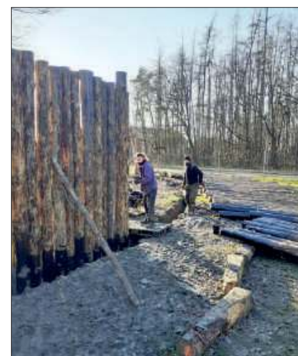
Przed wzniesieniem palisady konieczne było wytyczenie jej śladu oraz wykonanie wykopu, w którym następnie osadzono (uprzednio okorowane) belki
