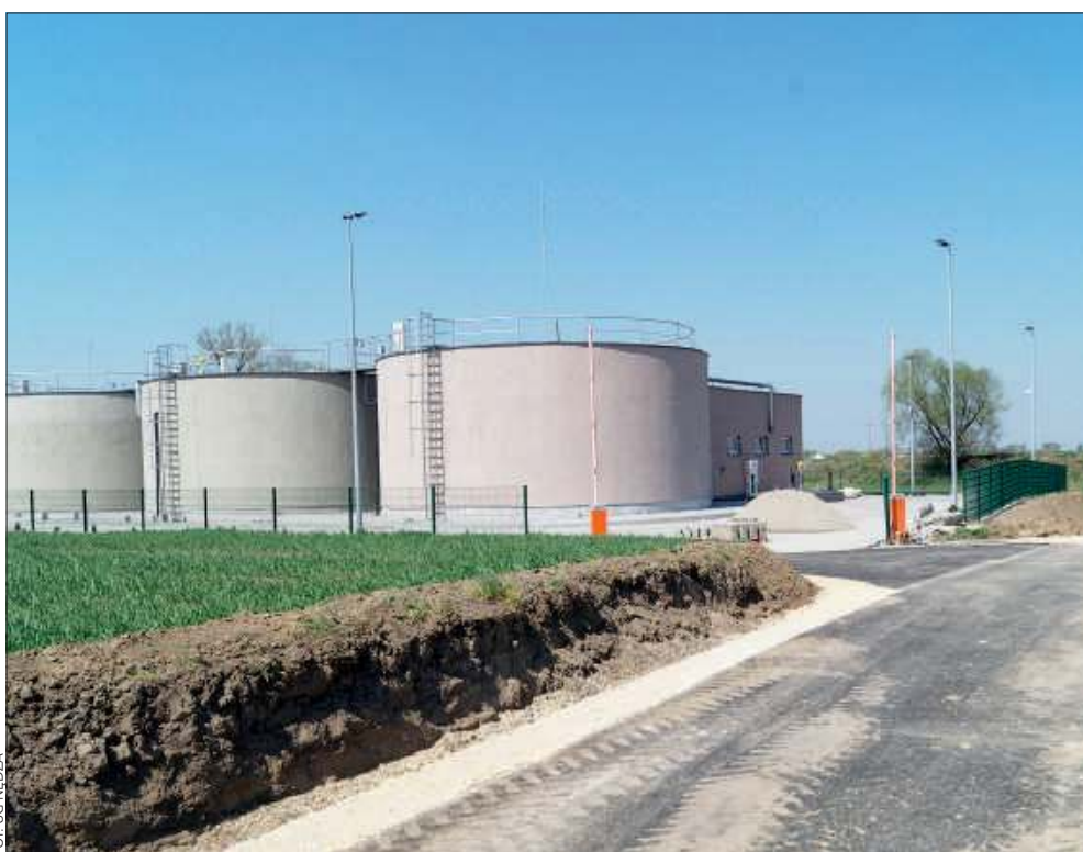
To oczyszczalnia ścieków, która powstała w Ciechowicach. Inwestycja opiewa na 8,6 mln zł, z czego dofinansowanie ze strony UE wynosi 4,7 mln zł, a z WFOŚiGW w Katowicach – 1,5 mln zł. Natomiast wkład własny gminy to około 3 mln zł.
