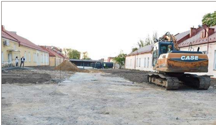
Teren pomiędzy biblioteką i galerią to obecnie plac budowy.
