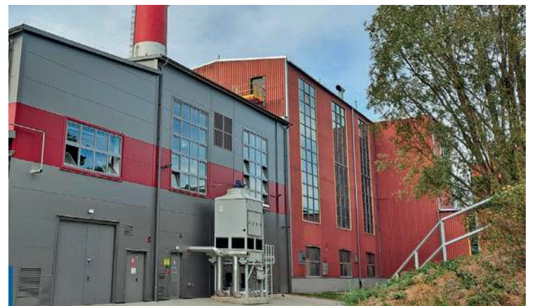
Elektrociepłownia w Ciechanowie
